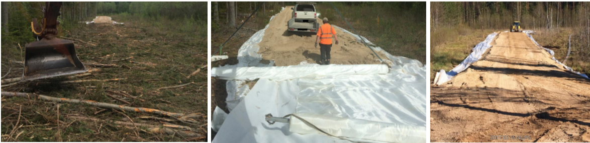
Fotod 22...24. Näide kruuskattega tee ehitamisest turbapinnasele: väga vesistes kohtades kasutati puuoksi täiendava koormusjaotuse huvides, looduslikku pinda ei rikutud, vaid selle peale paigaldati armeeriv geotekstiil, mille all oli veel kaitsev mittekootud geotekstiil. Armeeringu laius oli min 1 m muldkehast laiem, mis tagas selle, et tee vajumisel tõusid üles ka geotekstiili ääred. Fotod: Sven Sillamäe.
