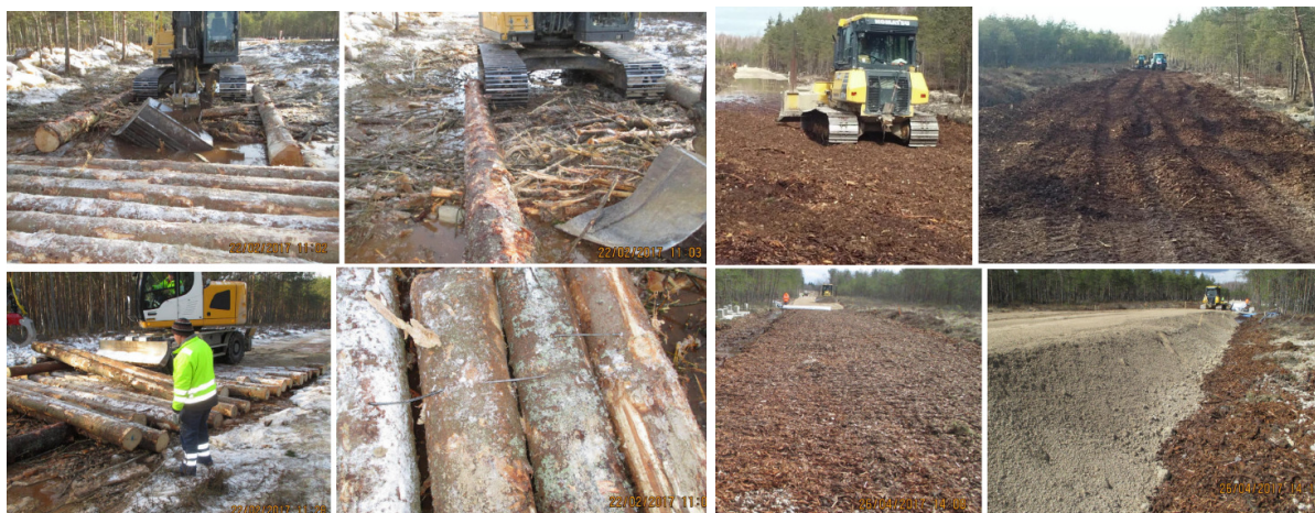
Foto 16. Üheks sobilikuks viisiks, kuidas ehitada (metsa)teed üle raba eriti keerulistes tingimustes (kõrged veesisaldused ja paksud turbakihid), on puitparvede ja puukoorest kergetäitematerjali kasutamine. Fotod: Sven Sillamäe.
