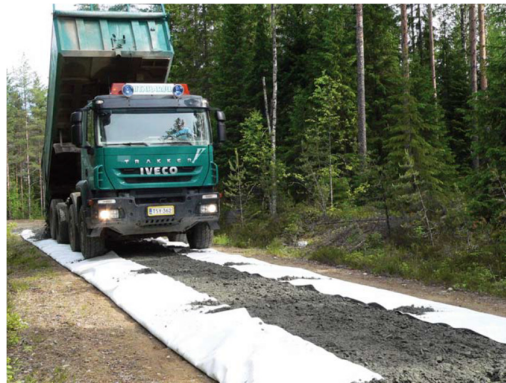
Joonis 15 ja foto 14. Kasutades katendi tugevdamisel kootud geotekstiili, tuleb ääred ankurdata. Geovõrkude puhul ei ole see vajalik. Joonis allikast [16], foto [8].
