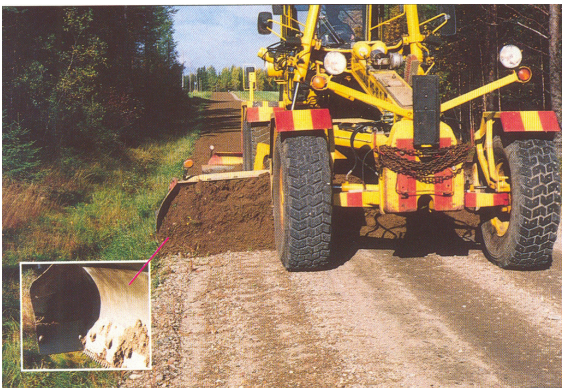
Foto 29 ja joonis 47. Kruusatee tasandushööveldamine [18] ning vajaliku lõikesügavuse defineerimine [19].
