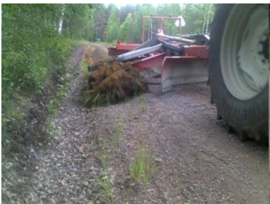
Foto 33 ja 34. Tee ääres oleva kulumiskihi materjali tagasi toomine. Kui tee ääred on juba kinni kasvanud, on võimalik taimesti ja humus eemaldada selleks ettenähtud freesiga. Fotod allikatest [19] ja [20].
