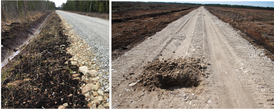
Foto 20 ja 21. Tee ja kraavi vahele jäetud ca 50...100 cm koormamata ala on eriti oluline nõrkade pinnaste esinemise korral. Parem pool näide metsateest, vasakul turbamaardla hooldusteest. Fotod: Sven Sillamäe.
