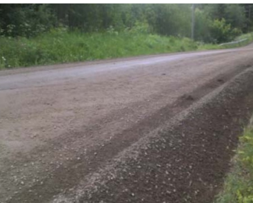
Foto 33 ja 34. Tee ääres oleva kulumiskihi materjali tagasi toomine. Kui tee ääred on juba kinni kasvanud, on võimalik taimesti ja humus eemaldada selleks ettenähtud freesiga. Fotod allikatest [19] ja [20].
