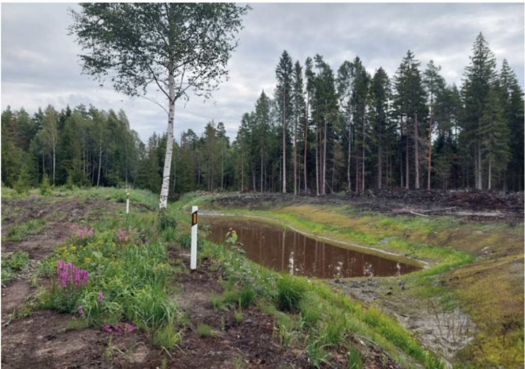
Rumba maaparandussüsteemil toimub veekvaliteedi ja -režiimi seire kõdusoometsade kraavidel ning lisaks 2023. aastal rajatud settetiikidel ja puhastuslodudel. Puhastuslodu väljavoolul reguleerib veetaset ja aitab vooluhulkasid seirata kolmnurk-ülevool. Autor: Margit Kõiv-Vainik
