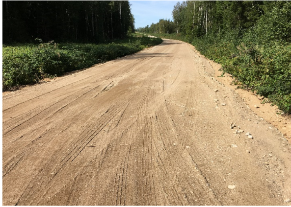
Foto 25. „Spetsiaalse“ kulumiskihita kruusliivast ehitatud juurdepääsutee. Foto: Sven Sillamäe.
