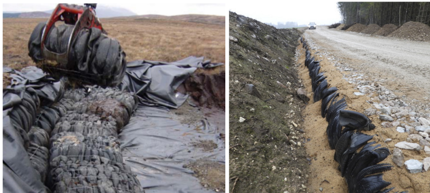
Fotod L2.3 ja L2.4. Rehviplokkid paigaldatuna teekonstruktsiooni vältides pinnasega kokkupuudet kui täites tühimikud materjaliga. Fotod: Roadex.org ja Sven Sillamäe.
