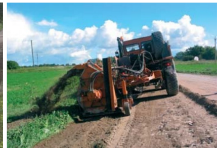
Foto 33 ja 34. Tee ääres oleva kulumiskihi materjali tagasi toomine. Kui tee ääred on juba kinni kasvanud, on võimalik taimestik ja humus eemaldada selleks ettenähtud freesiga. Fotod allikatest [19] ja [20].
