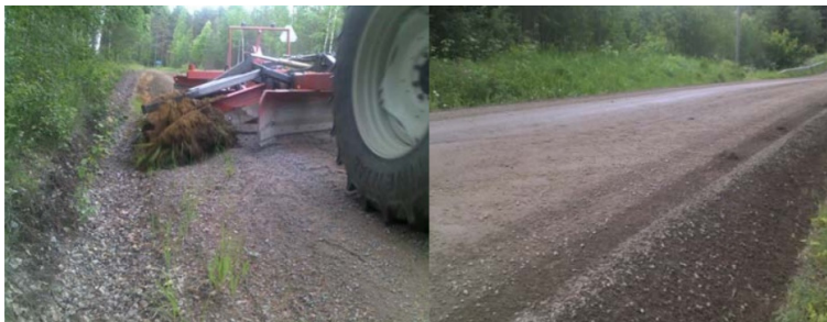
Foto 33 ja 34. Tee ääres oleva kulumiskihi materjali tagasi toomine. Kui tee ääred on juba kinni kasvanud, on võimalik taimestik ja humus eemaldada selleks ettenähtud freesiga. Fotod allikatest [19] ja [20].
