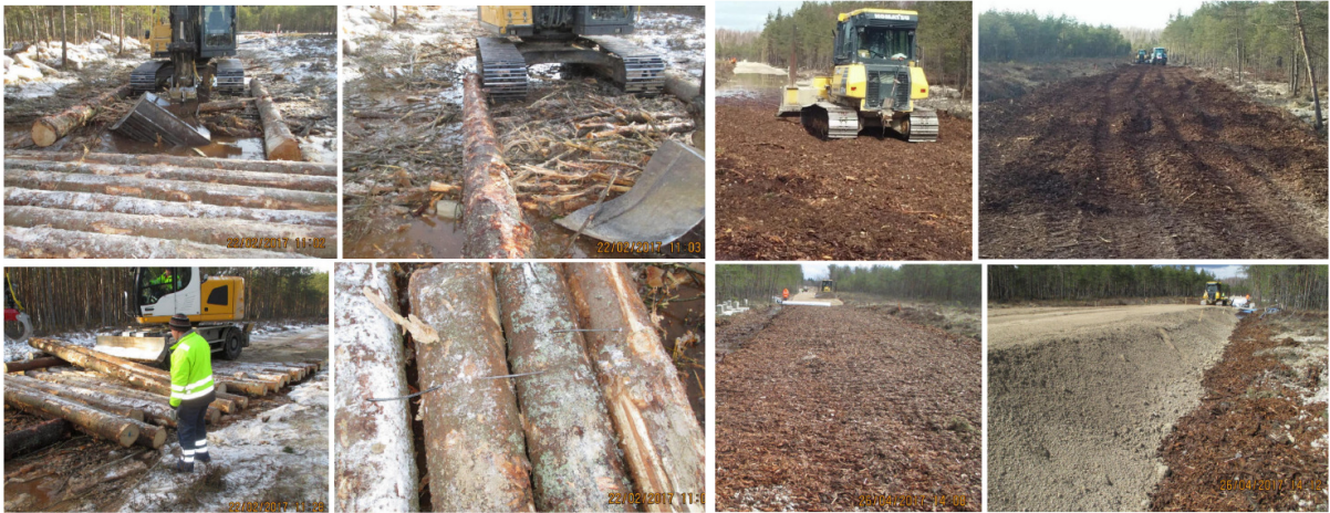
Foto 16. Üheks sobilikuks viisiks, kuidas ehitada (metsa)teed üle raba eriti keerulistes tingimustes (kõrged veesisaldused ja paksud turbakihid), on puitparvede ja puukoorest kergtäitematerjali kasutamine. Fotod: Sven Sillamäe.
