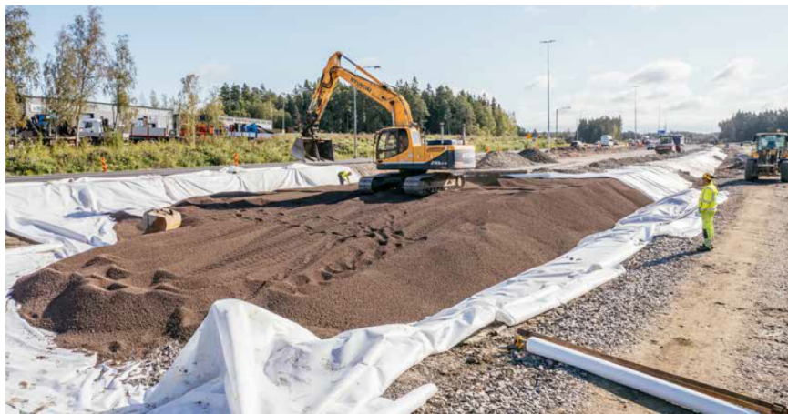
Foto L2.1. Kergkruusa paigaldamine teekonstruktsiooni (sarnaselt toimub paigaldus ka kergkillustikuga). Kergkruus laotatakse ja tihendatakse kas roomikekskavaatori või buldooseri, millega antakse ka esmane tihedus, ümbritsetakse geotekstiiliga ning kaetakse 0,15...0,20 m mineraalmaterjalikihi, mille pealt antakse vibrorulliga lõpptihedus. [Leca]
