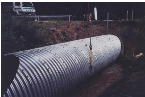
Foto 19. Uue toru asetamine vana toru sisse [45]
