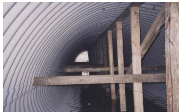
Foto 20. Uue toru asetamine vana toru sisse [45]
