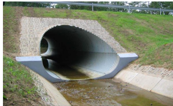
Foto 8. Kiviplokkidega kindlustamine (foto: Gediminas Viršilas [29])
