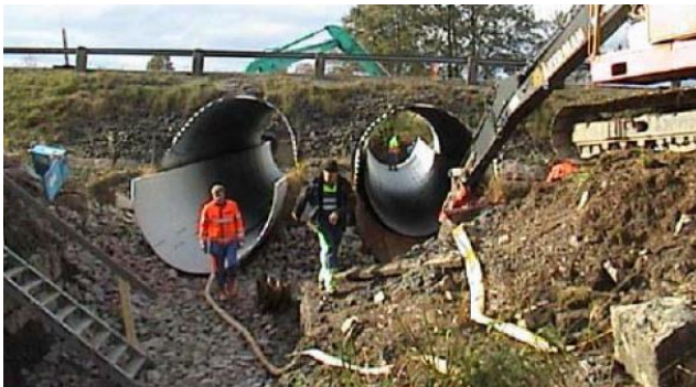
Foto 17. Truubi renoveerimine uue põhja ehitamisega [29]
