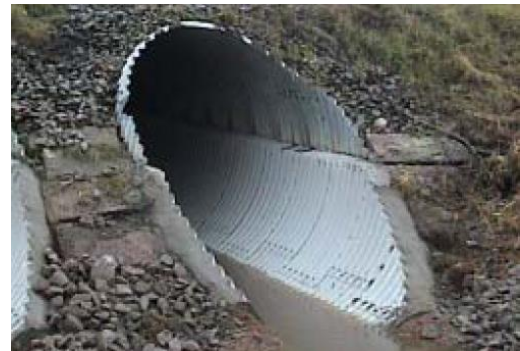
Foto 18. Truubi renoveerimine uue põhja ehitamisega [29]
