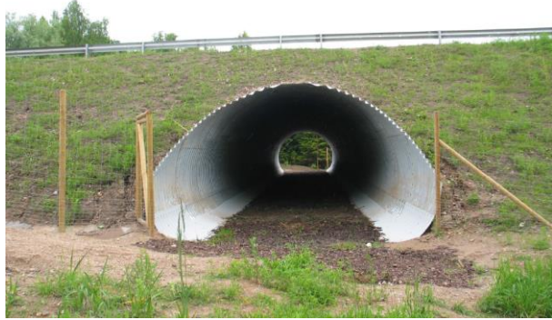
Foto 2. Muruga kindlustamine (foto: Gediminas Viršilas [29])
