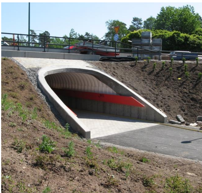
Foto 11. Serva kaitsmine raudbetoonist servaprussiga (foto: Martti Kiisa)
