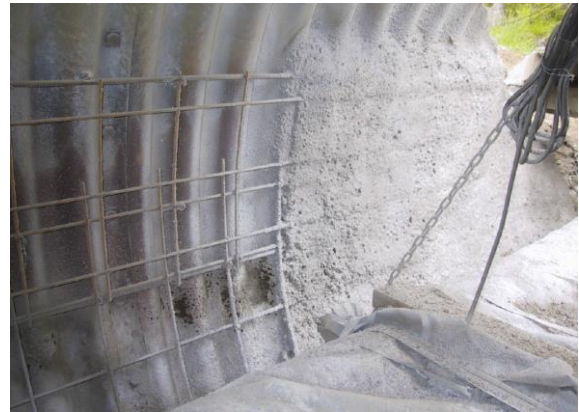
Foto 16. Truubi alaosa renoveerimine pritsbetooniga [45]
