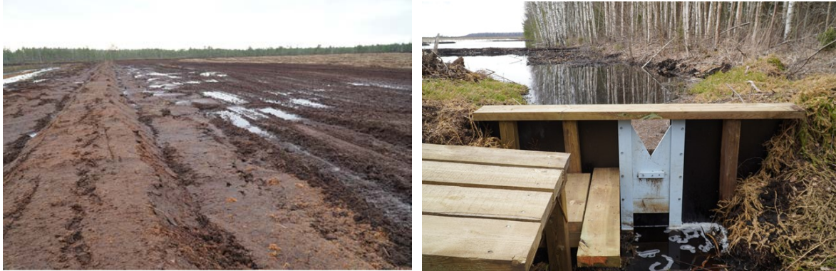
Joonis 29. Pinnasvall jääsoode eraldajana (vasakul) ning lihtne kuid tõhus reguleeritav ülevool veetaseme reguleerimiseks. Selliseid ülevoole tuleks kasutada iga hüdroloogiliselt eraldatud jääsoo eraldusvalli juures.
