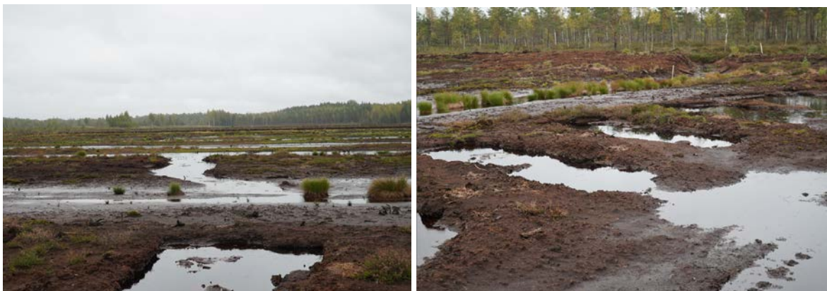
Joonis 55. Näide meandreeruvast paisudega suletud kraave ühendavast voluteest (vasakul) ning liiga kõrget veetaset vältivast volunõvast (paremal).
