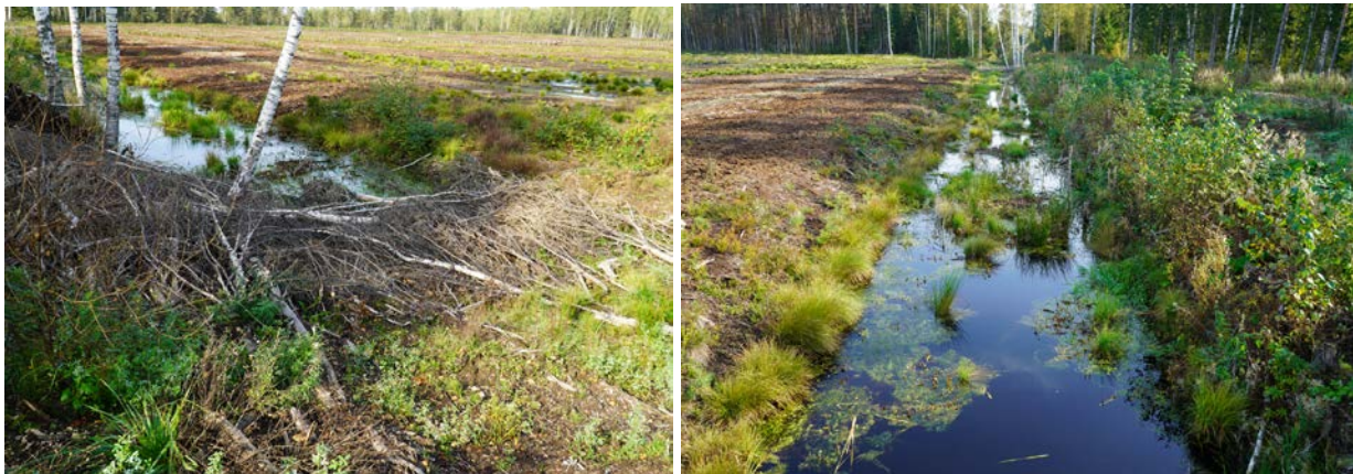
Joonis 53. Avatuks jäävatel kraavilõikudel haost või põhupallidest tõkete tekitamine/säilitamine on kasulik nii heljumi kahandamiseks kui kraavi kinnikasvaise kiirendamise seisukohast. Kogujakraav K-17 on tõketevahelisel lõigul täitumas turbasammalde, ubalehtede, soovõhkade, villpeade ja tarnadega.
