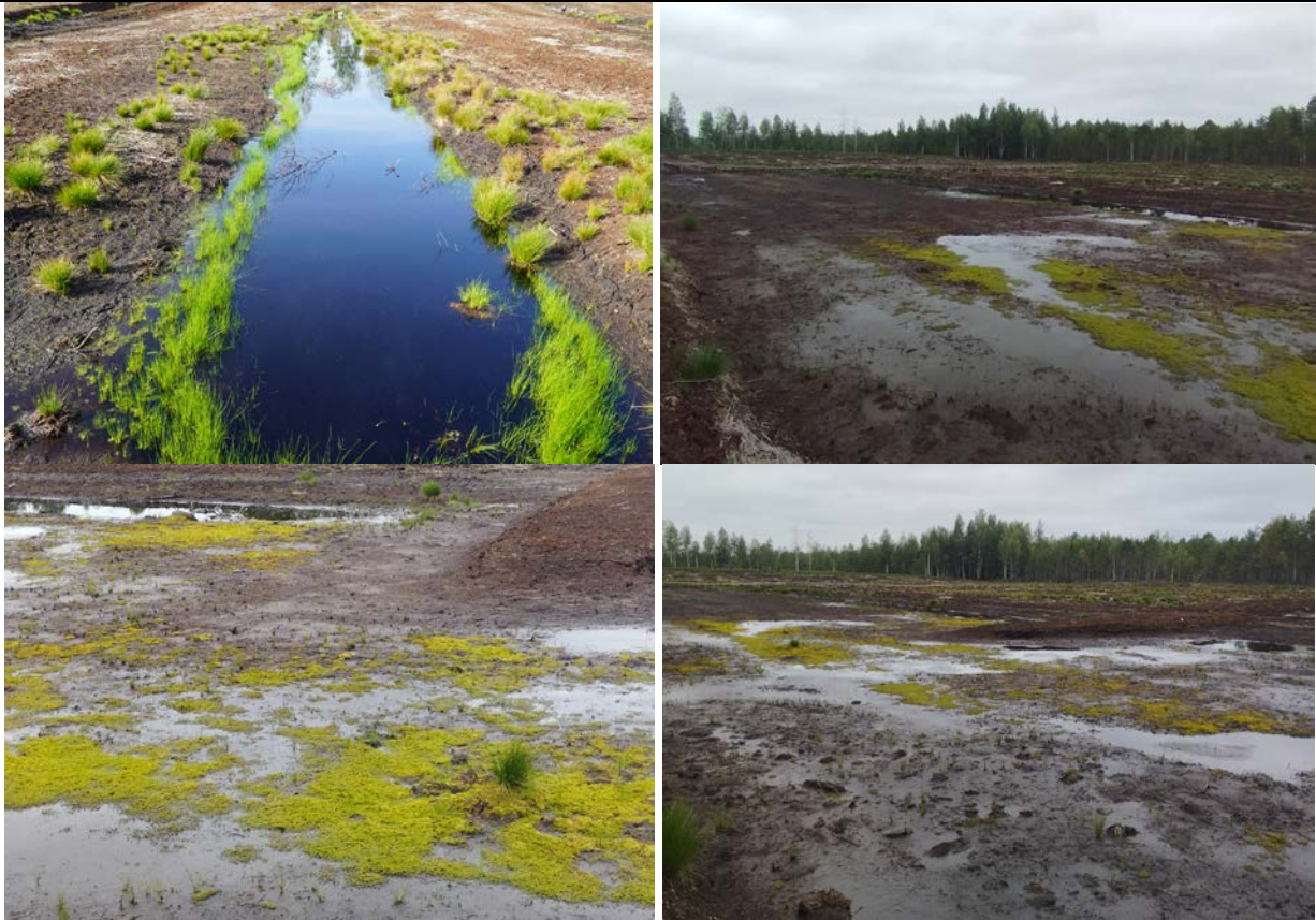
Joonis 49. Pinnaspaisudega kraavid hoiavad ka arvestatava nõlvakalde korral edukalt veetaset üleval. Samblafragmentide laotamine sel alal (1, L) pole enamasti sama edukas kui kraavide lausalise täitmiseega naaberalal (2, N), kuid sobiva niiskusega piirkonnas on kujunenud ulatuslik lausalise turbasambla katvusega ala. Taimestumine toimub edukamalt ka kraavide kallastel, aga traavidevahelistel väljakutel on taimestik hõre ning elusaid turbasamblaid vähem kui naaberalal. Kas samblafragmendid on säilitanud kahe põuase suve järel elujõu, selgub järgnevatel aastatel.
