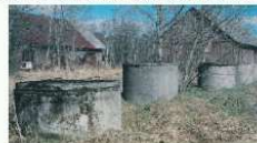
1960-tel ehitatud Kullamaa metskonna töökoja reovee puhastusseade - esimesi metskondades
