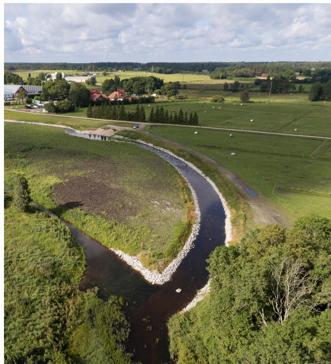
Taastatud jõesäng ja pinnasega täidetud paisjärve ala. Foto: Triin Leetmaa
