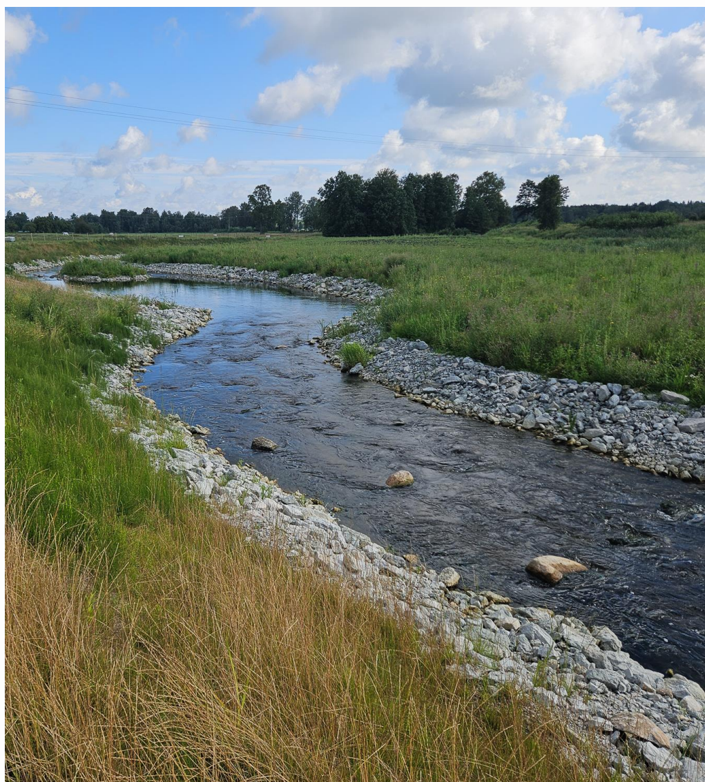
Taastatud jõesängi kaldad kindlustati killustiku ja põhumattidega. Foto: Triin Leetmaa
