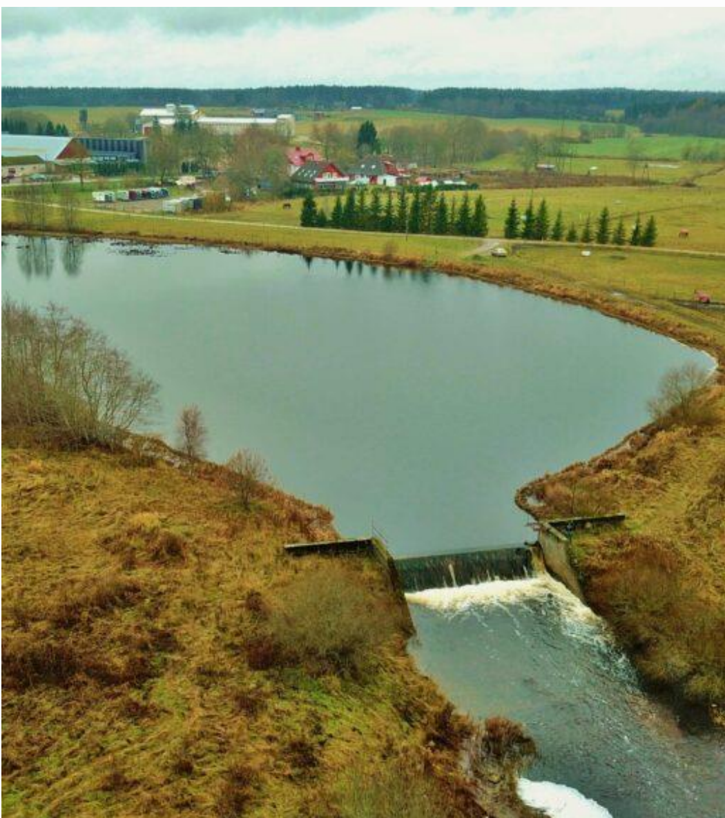
Ruila pais ja paisjärv enne töid. Foto: RMK
