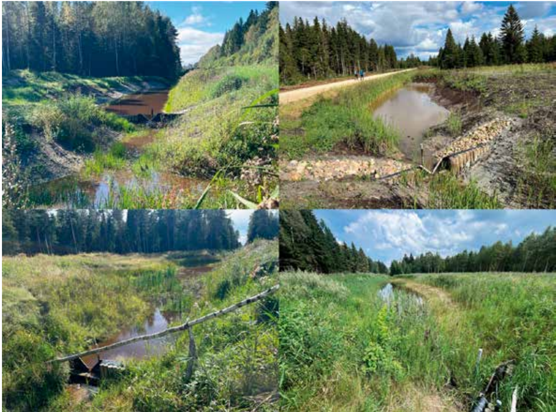
Joonis 2. Projekti käigus rajatud seiratavad veekaitsemeetmed 2025. aastal. Ülemises reas settebasseinid (SB1 vasakul, SB2 paremal), alumises settebasseinid kombineeritud osaliselt taimestunud puhastuslodudega (SB + PL1 vasakul, SB + PL2 paremal). Vooluhulkade mõõtmiseks rajati seiratavate veekaitsemeetmete väljavooludele kolmnurk-ülevoolud ja paigaldati automaatne veetaseme mõõtja.
