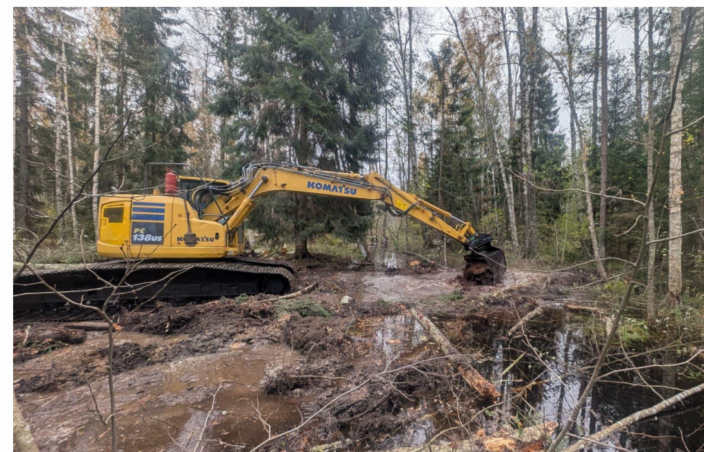
Ekskavaator kuivenduskraavi sulgemas. Foto: Märt Reha
